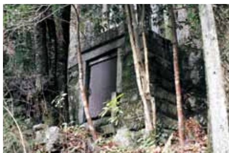
出土品を一時保管していた石蔵
