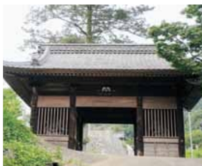
天和3年(1682)に修理された仁王門 昭和55年(1980)に茅葺きから瓦葺きに改修した。
