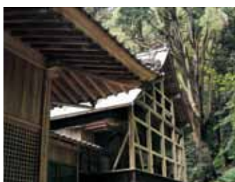
御神殿(檜皮葺き)の上に屋掛けしてある。
